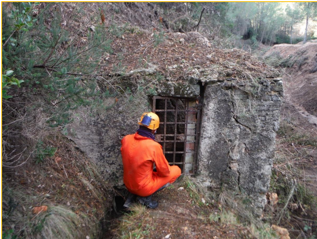
Una de les entrades a l'Alcavor de la Vall Seca. Aquest complex subterrani és un dels més importants del terme d'Ontinyent. La funció del seu entramat de galeries és la captació i conducció d'aigua, i en l'actualitat continua actiu.
